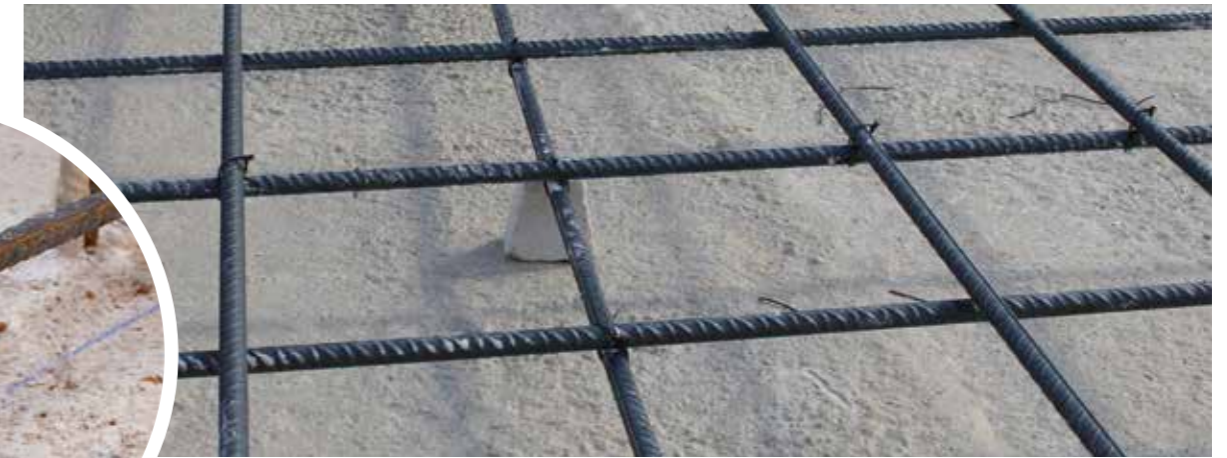
Separador cubito Concrete cube spacer Cale béton bloc
