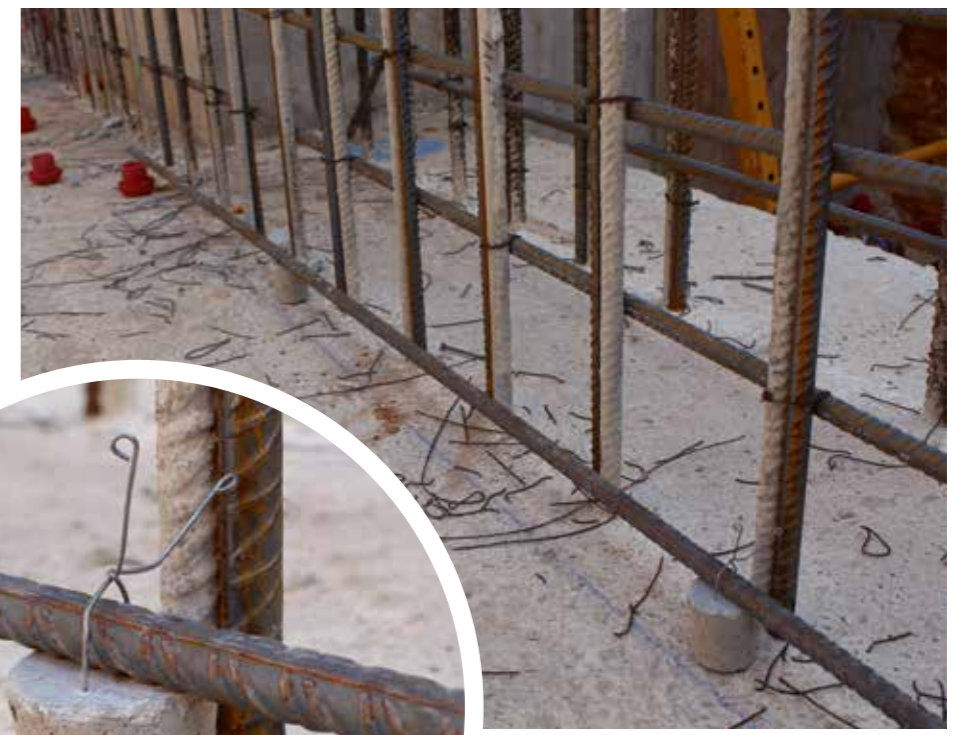
Taco con alambre Concrete spacer with wire Taco avec câble
