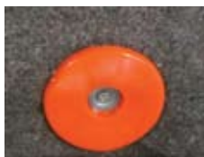
Fixação de isolamento em tuneis
